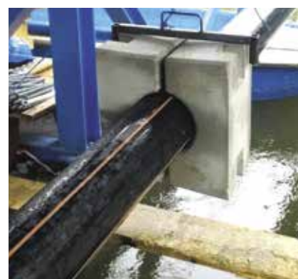
Buter les éléments de lests d'un tube ou ancrer un tube dans un mur
