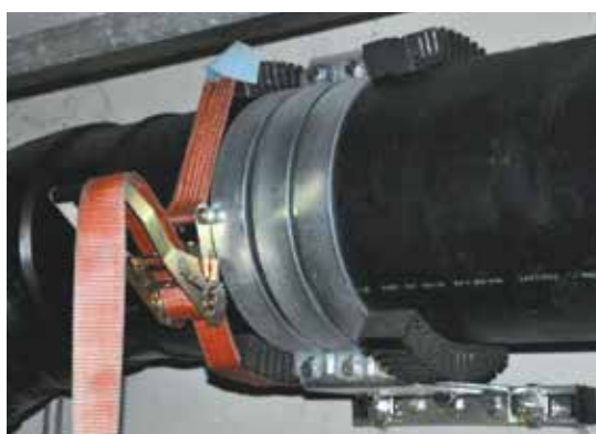
Création de points fixes pour buter des raccords
