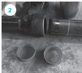
Vérifier la propreté du joint et de la bague de verrouillage.
