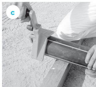
Réaliser le chanfrein à l'aide d'une chanfreineuse suivant les dimensions ci-dessus.
