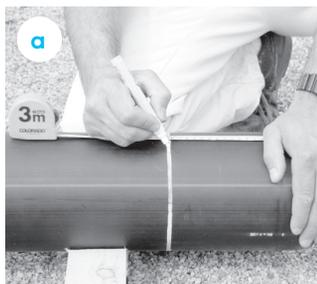
Tracer le plan de coupe perpendiculairement à l'axe du tube.
