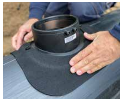
Le tapis d'étanchéité en caoutchouc auto-adhésif mat permet le maintien de la selle sur un tube ASA VL d160.
