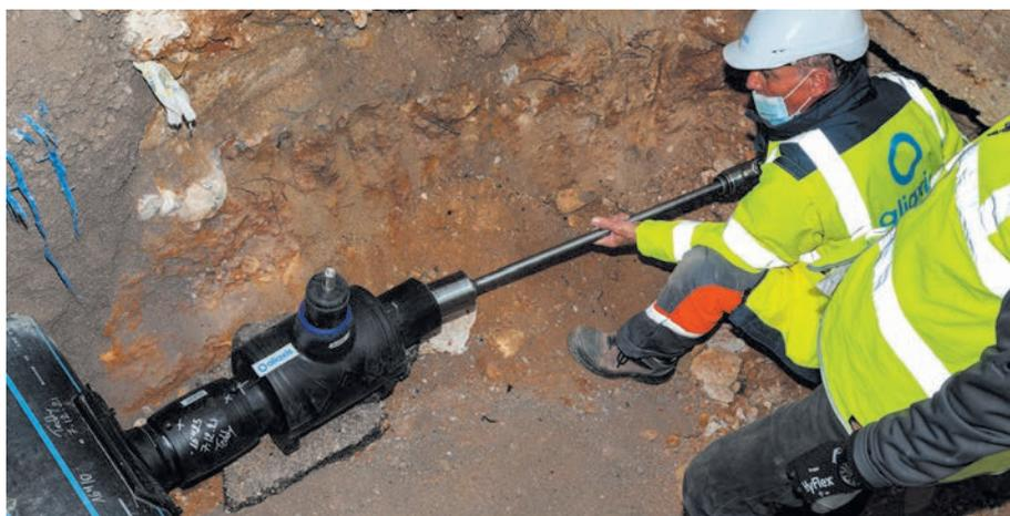
Outil de perçage en charge dédié. Permet de réaliser vos branchements sans arrêt de vos réseaux d'eau.
