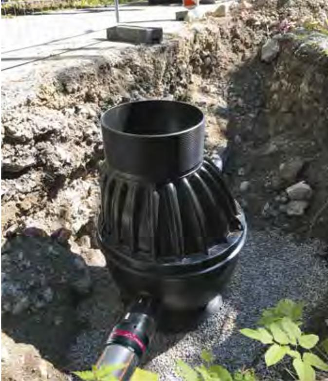
La grande souplesse d'adaptation du regard modulaire permet de corriger les éventuels défauts de terrain et d'obtenir un réseau homogène sans perte d'étanchéité.
