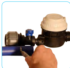
1. Repérer la longueur de tube nécessaire.
