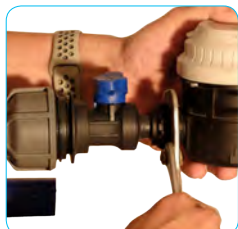
5. Serrer l'écrou libre sur le compteur ; finir d'1/4 de tour à la clef.
