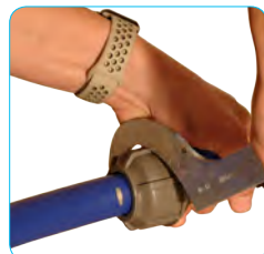
7. Serrer l'écrou à compression à fond.
