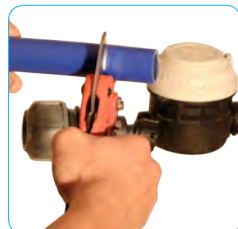
2. Couper le tube PE à la longueur requise avec un outil approprié
