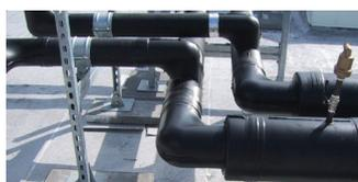
Basé sur le système ABS SuperFlo, le DuraCool est une gamme de tubes, raccords et robinetterie pré-isolés permettant de conserver un fluide à température afin
