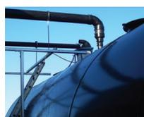
Système en PE 100 revêtu conçu et développé par Durapipe pour répondre aux inquiétudes environnementales liées aux émissions de COV et pour se prémunir contre la contamination potentielle des eaux souterraines.
